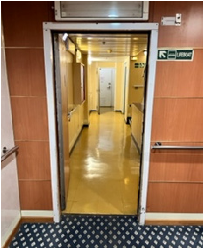
7. PORTA USCITA ASCENSORE "H" PONTE 7: Ingresso galleria 80cm
