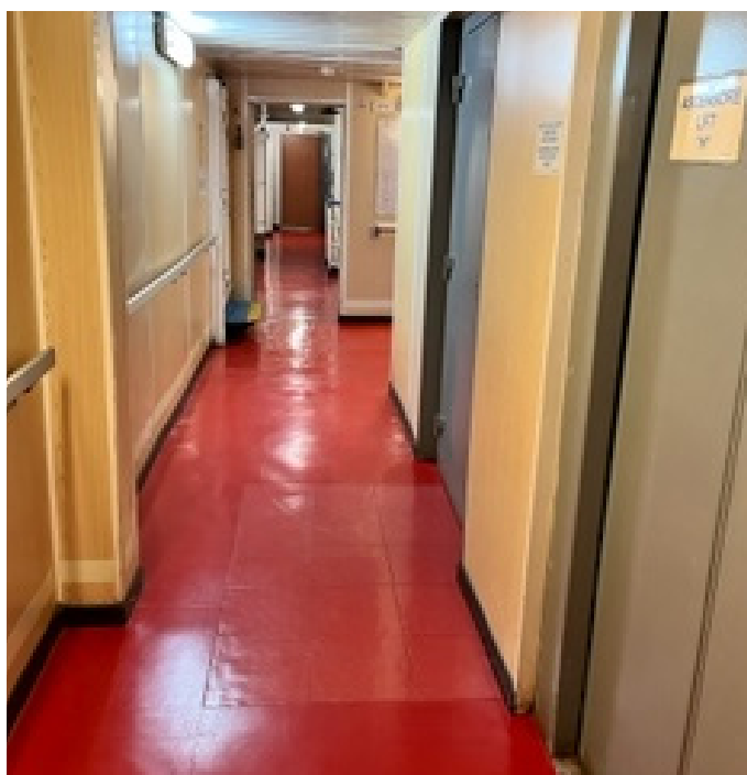
6. CORRIDOIO PONTE 6: USCITA ASCENSORE "H" Minima larghezza 95cm Porta uscita reception 80cm Distanza ascensore – reception 21m
